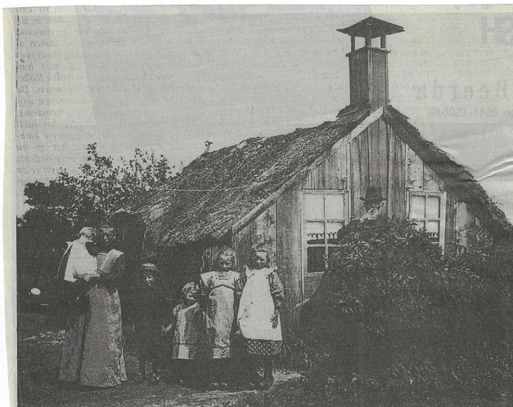
Houten éénkamerwoning met rieten dak in N.O. Friesland omstreeks 1910.
